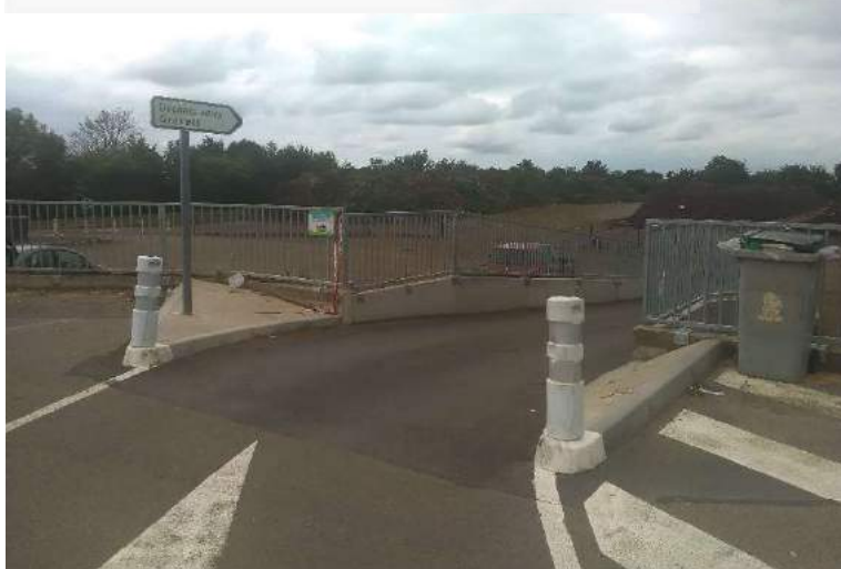
Azé – Rampe d'accès Gravats – Déchets verts
